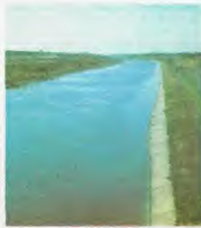
Каховська зрошувальна система. Магістральний канал.
